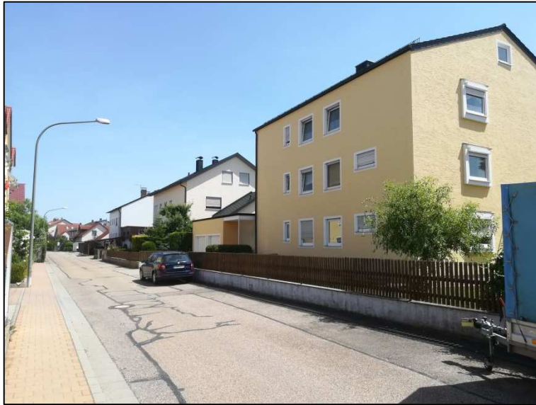
Blick von Nordwesten nach Osten in den Meisenweg. Zwei- bis dreigeschossige Bebauung.
